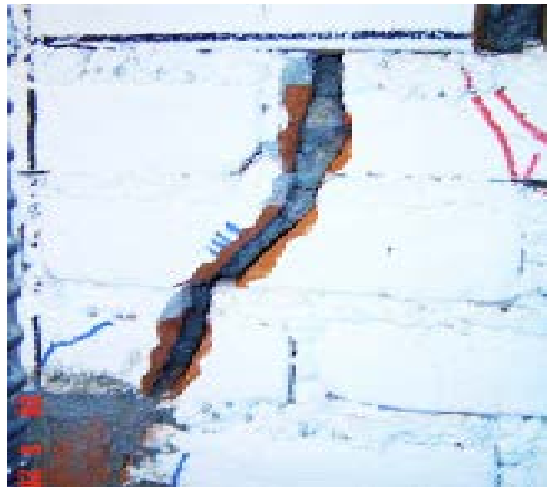
Figura 6.7.1 Reparación de grietas mediante relleno con mortero (Flores et al.,2004).
