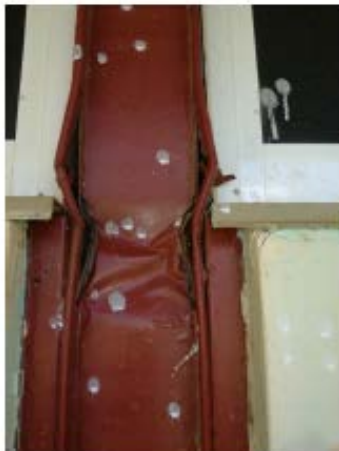
Figura 1.3.5 Pandeo local de placas y rotura de soldaduras en columnas de acero por efecto de columna corta (INIFED, 2019)
