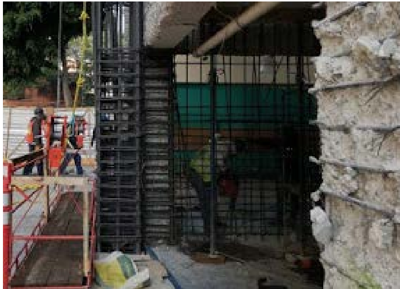
Figura 6.8.9 Muros excéntricos conectados a la estructura original por medio de encamisados de columnas
