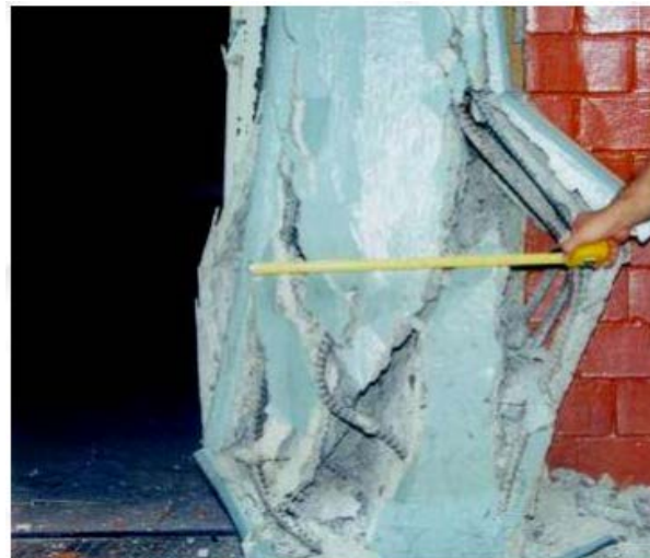
Figura 1.3.3 Falla por flexocompresión en columnas (INIFED, 2019)
