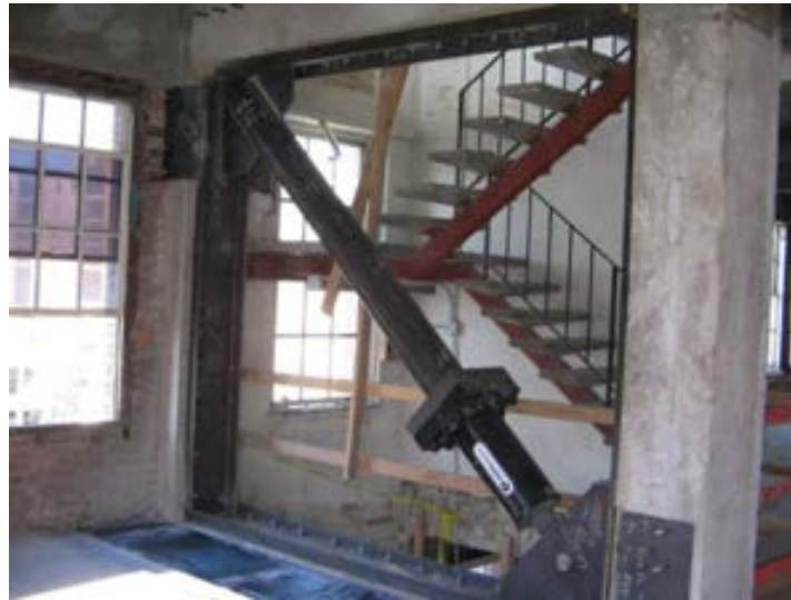
Figura 6.9.11 Adición de contraventeo con amortiguador viscoso en un marco de concreto (Ministerio de Educación, Cultura, Deporte, Ciencia y Tecnología de Japón, 2006)
