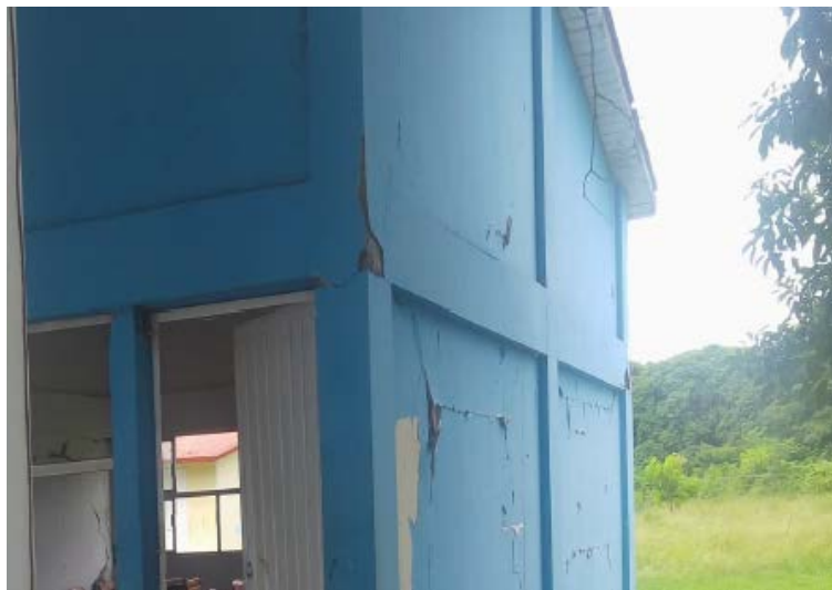
Figura 1.3.7 Agrietamiento del concreto en uniones viga-columna (INIFED, 2019)
