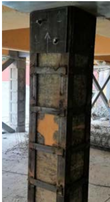
Figura 6.5.10 Encamisado de columna con placa con conectores en el extremo
