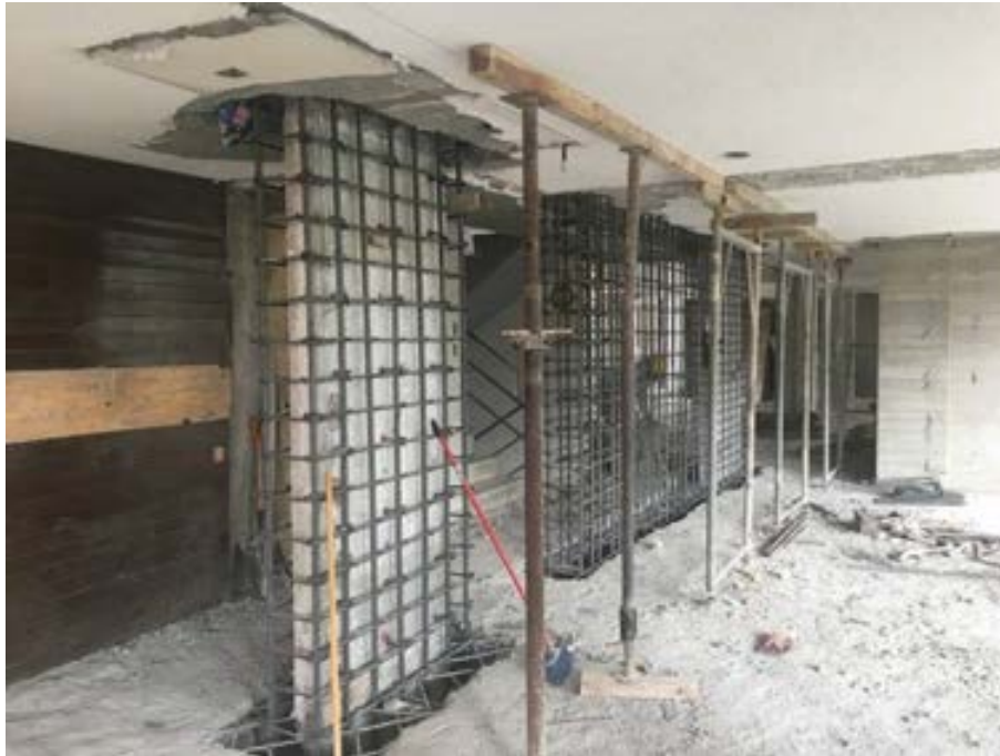
Figura 6.8.3 Demolición de concreto de sistema de piso sin dañar acero de refuerzo original
