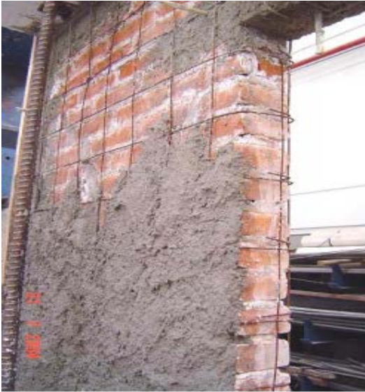
Figura 6.7.8 Colocación de mortero sobre la malla. (Flores et al., 2004) (Alcocer, 2019)
