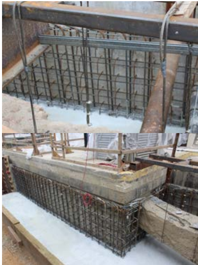
Figura 5.4.1 Esquema de refuerzo perpendicular a la interfaz
