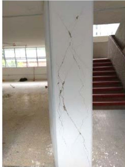
Figura 1.3.2 Agrietamiento inclinado en columnas de concreto (INIFED, 2019)
