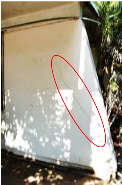
Figura 1.3.9 Agrietamiento inclinado en un contrafuerte (Alcocer et al., 2018)
