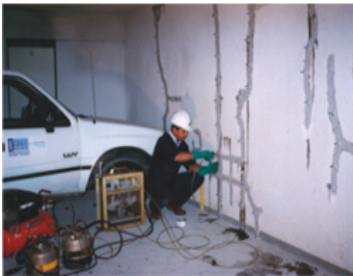
Figura 6.2.4 Inyección de resina con bomba mecánica, (REPES Chile, 2016)
