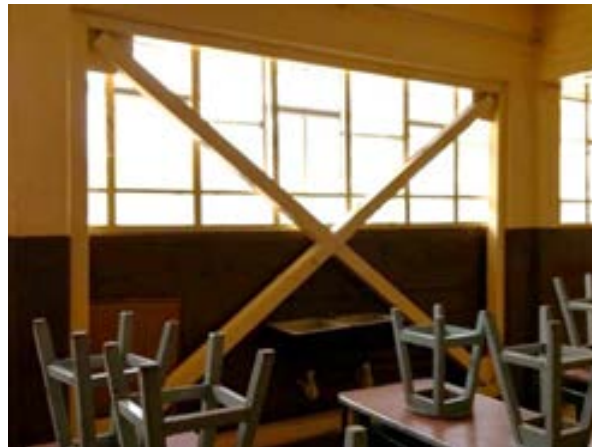
Figura 6.9.21 Escuela rehabilitada con contraventeos de acero tipo X (Ministerio de Educación, Cultura, Deporte, Ciencia y Tecnología de Japón, 2006)
