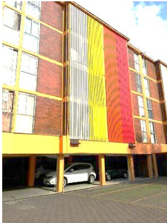
Figura 6.5.1 Edificio con planta baja flexible
