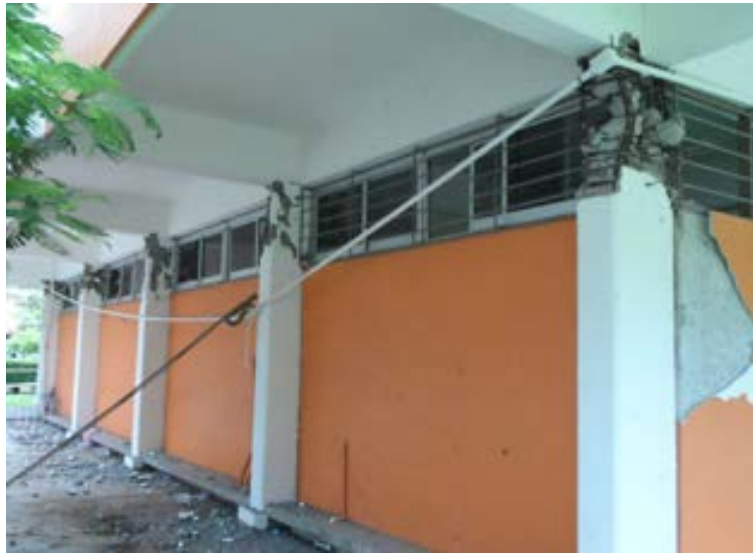
Figura 1.3.4 Falla por columna corta en marcos de concreto (INIFED, 2019)
