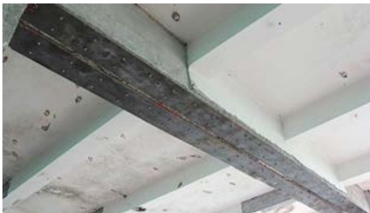
Figura 6.5.2 Encamisados de vigas con placas de acero (Horse Construction Company China, 2019)
