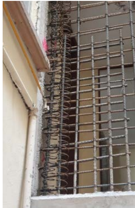
Figura 6.8.2 Refuerzo helicoidal vertical en muros
