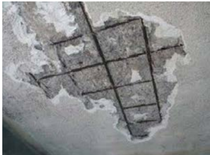
Figura 1.3.6 Desprendimiento de concreto en losas debido a corrosión del acero de refuerzo (INIFED, 2019)
