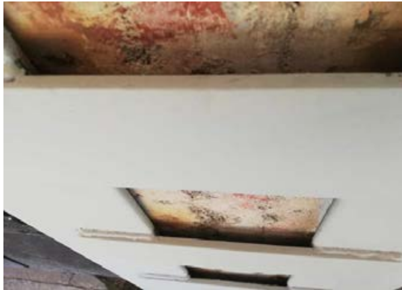
Figura 6.5.12 Espacio vacío entre las soleras y el concreto
