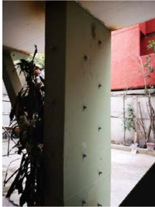
Figura 6.5.11 Distribución de conectores en encamisado de placas de acero
