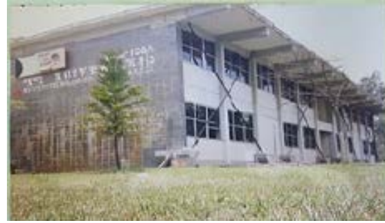
Figura 6.10.1 Rehabilitación a base de cables postensados (CAPFCE, 1986)
