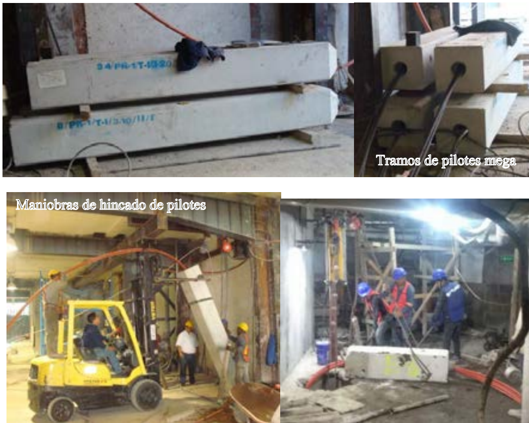
Figura 6.14.4 Pilotes tipo mega
