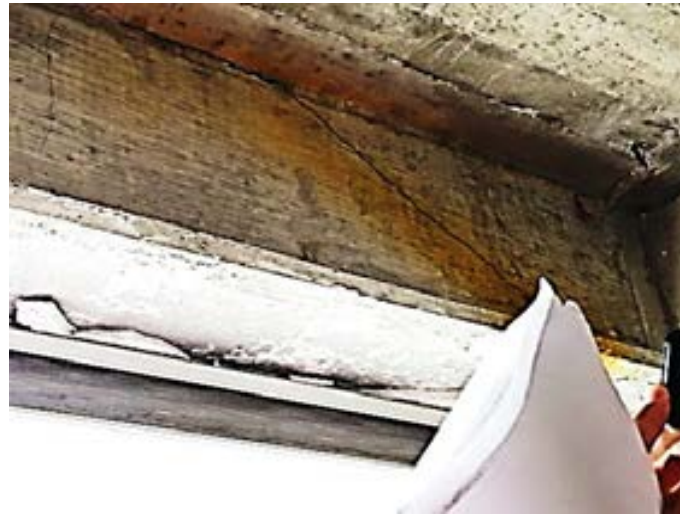
Figura 6.2.1 Identificación y descubrimiento de la grieta de acabados adyacentes
