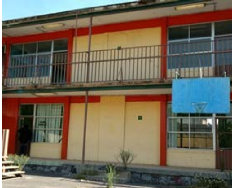
Figura 6.8.11 Escuela rehabilitada con muros de concreto reforzado (Alcocer et al., 2018)
