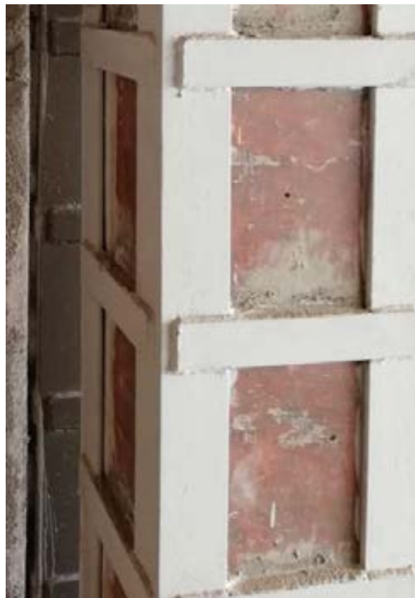
Figura 6.5.13 Mortero correctamente aplicado entre las soleras y el concreto
