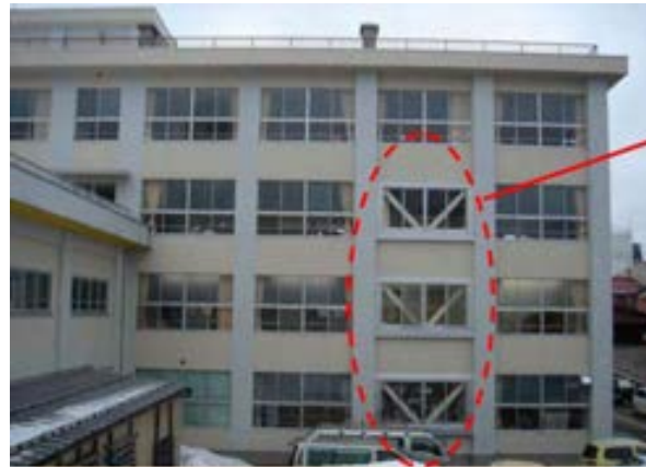
Figura 6.9.22 Escuela rehabilitada con contraventeos de acero en forma de letra V (Ministerio de Educación, Cultura, Deporte, Ciencia y Tecnología de Japón, 2006)
