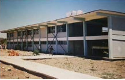
Figura 6.10.1 Rehabilitación a base de cables postensados (CAPFCE, 1986)
