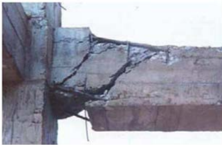
Figura 1.3.1 Agrietamiento inclinado en la viga debido a una separación grande de los estribos y a concreto de baja resistencia (Instituto Valenciano de la Edificación, 2019)
