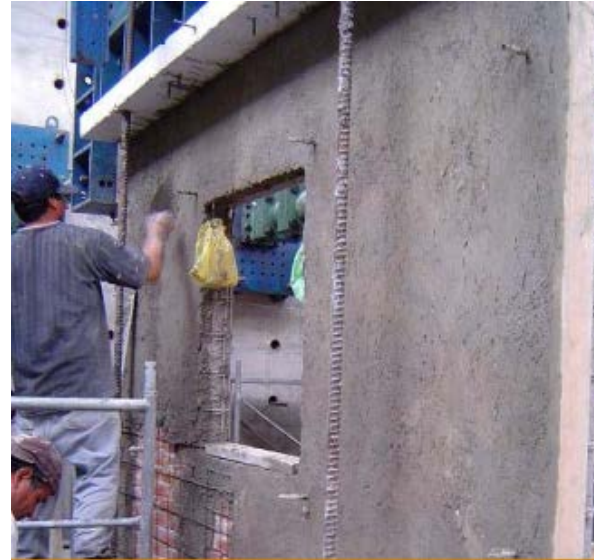
Figura 6.7.8 Colocación de mortero sobre la malla. (Flores et al., 2004) (Alcocer, 2019)
