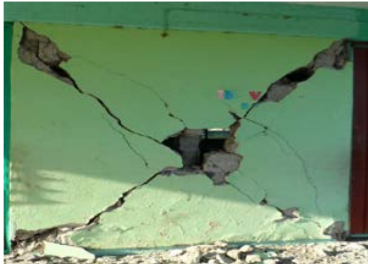
Figura 1.3.8 Agrietamiento inclinado en muros (INIFED, 2019)
