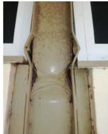
Figura 1.3.5 Pandeo local de placas y rotura de soldaduras en columnas de acero por efecto de columna corta (INIFED, 2019)
