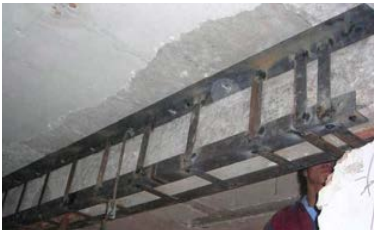
Figura 6.5.3 Encamisados de vigas con ángulos y soleras (Horse Construction Company China, 2019)
