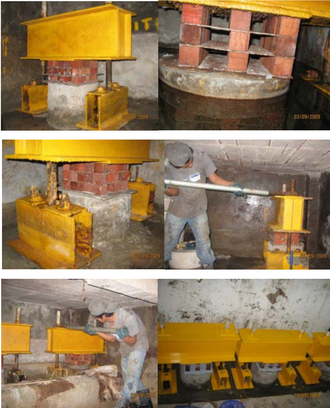
Figura 6.14.8 Pilotes de control (Cuevas, 2019)
