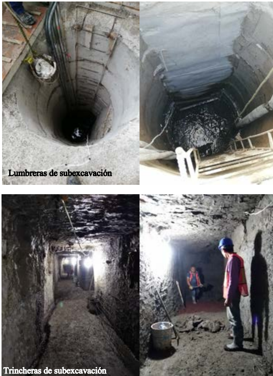
Figura 6.14.10 Lumbreras y trincheras de subexcavación (Cuevas, 2019)
