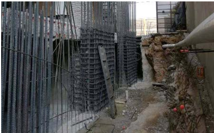
Figura 6.8.1 Adición de muro de concreto excéntrico
