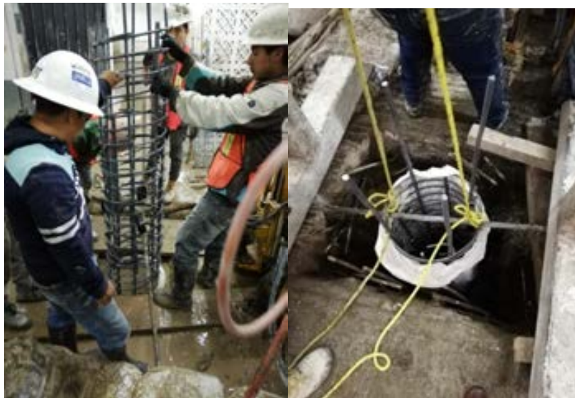
Figura 6.14.11 Pilotes colados en el lugar provistos de funda geotextil
