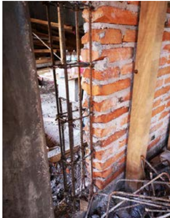
Figura 6.12.1 Escuela rehabilitada con encamisado de columnas de concreto, en la cual se han desligado los pretilas
