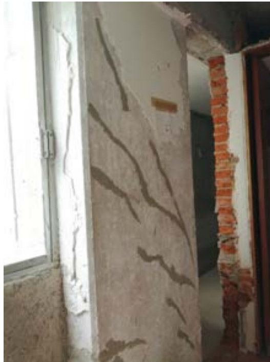
Figura 6.2.6 Columna de concreto después de la inyección
