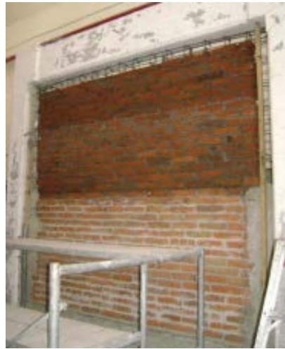
Figura 6.11.3 Escuela rehabilitada mediante la sustitución de muros diafragma de mampostería confinada
